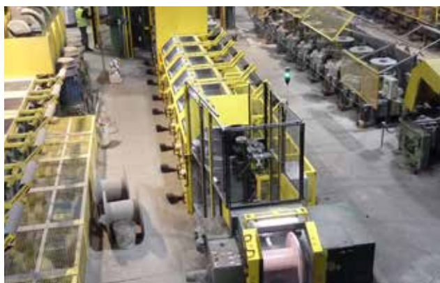
Rys. 8. Ciągarka po modernizacji
