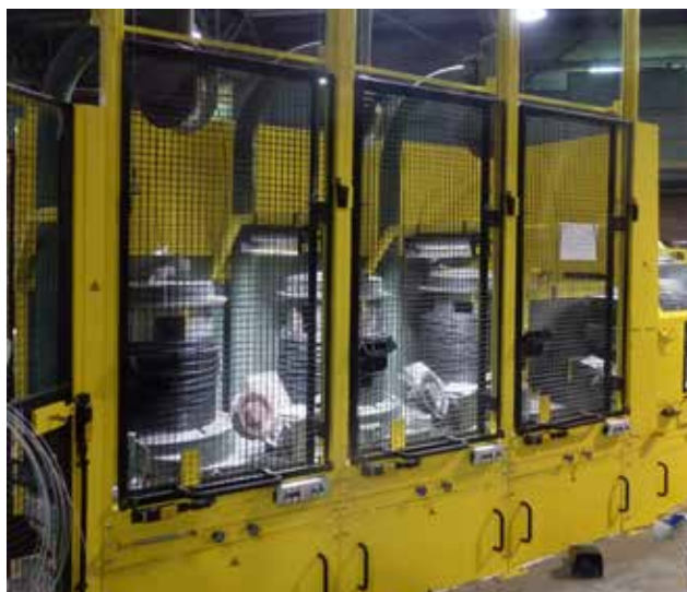
Rys. 4. Strefa dużych bębnow ciągnących po modernizacji
